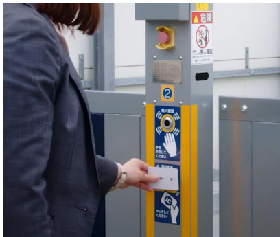
操作盤に IC カードをピットかざして入出庫
